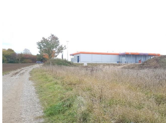
Abbildung 10: Waschanlage westlich des Geltungsbereiches (Blickrichtung Süden)
