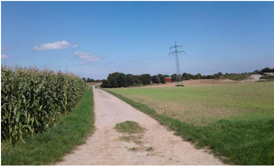
Abbildung 15: Blick Richtung Norden auf die Stromtrasse und die Ökokontofläche
